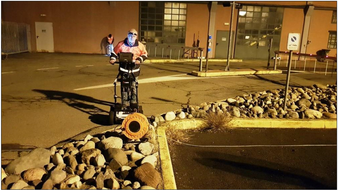
Completamento delle indagini mediante utilizzo di Radiodetection (Rilevatore elettromagnetico di sottoservizi e cavidotti in tensione)
